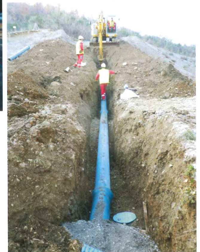
Reprise et renforcement du réseau de distribution d'eau potable du village et construction du réseau d'assainissement du village. Reprise des conduites défectueuses en parallèle des travaux d'assainissement des quartiers Gouvernas-Est et Joffres.
