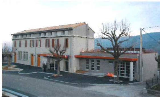
Réhabilitation de la Mairie avec création de 4 logements Vivaraïs Habitat. Bâtiment chauffé au bois
