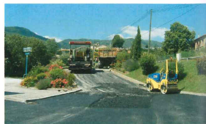
Réalisation en enrobé du parking salle du Charray.
