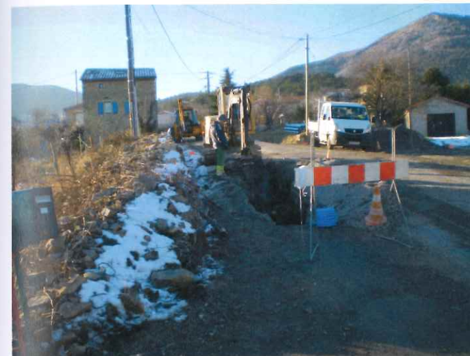
Extension du réseau d'assainissement Les Chazeaux, Les Vignes, Le Château, Gouvernas-Est.
